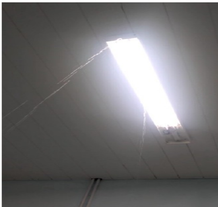
Figura 1 A imagem identifica infiltração pela fonte de iluminação do pavilhão 37 .
