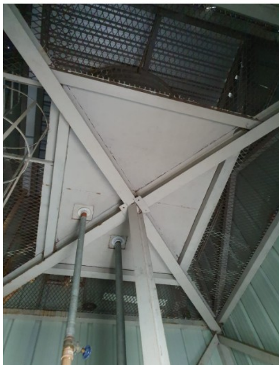
Figura 1- Estrutura de apoio ao reservatório de fibra de 20.000 litros
