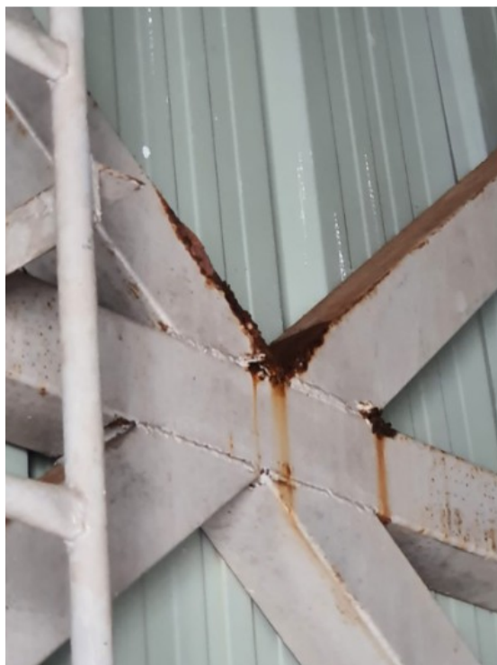
Figura 2 – Pontos de corrosão da estrutura metálica
